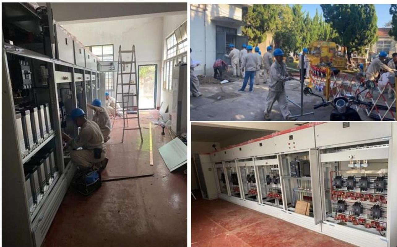
能源科对我校现存最早最老的 1 号配电房进行了改造，该配电房在为学校服务 30 多年后迎来了新生，以崭新的设备和面貌继续为学校东北区域楼宇稳定供电。
